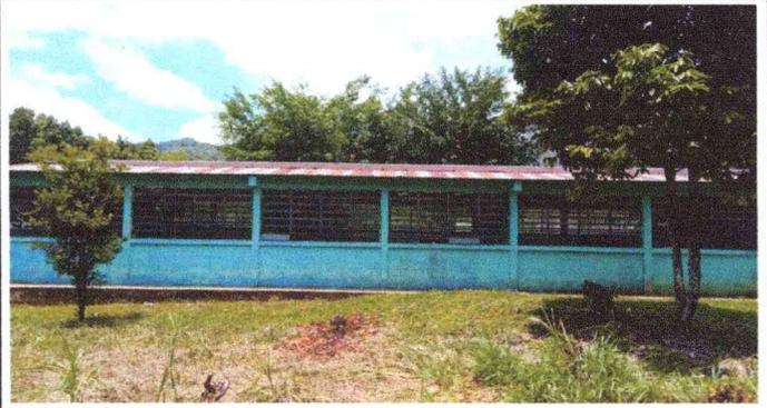
Foto 2: Se observa el techo en mal estado necesita ser sustituido
