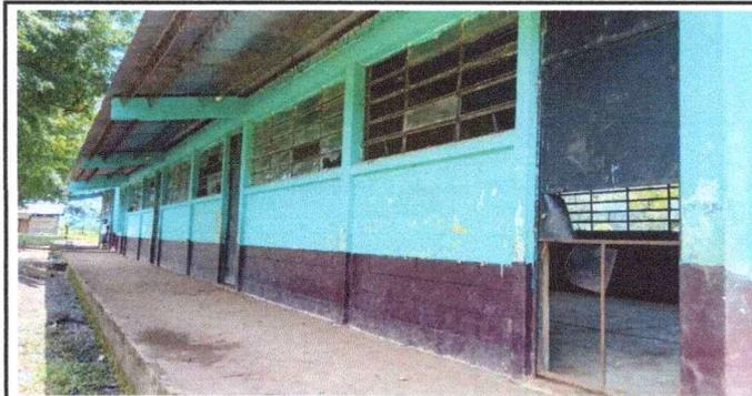
Foto 5: Se observa la puerta en mal estado, necesita ser sustituido
