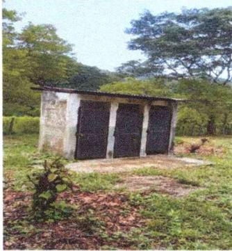
Foto 3: Se observa la puerta, lamina y pintura de los baños en mal estado, necesita ser sustituida
